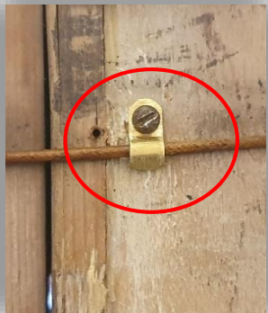
Ricostruzione dei passacavi mancanti
